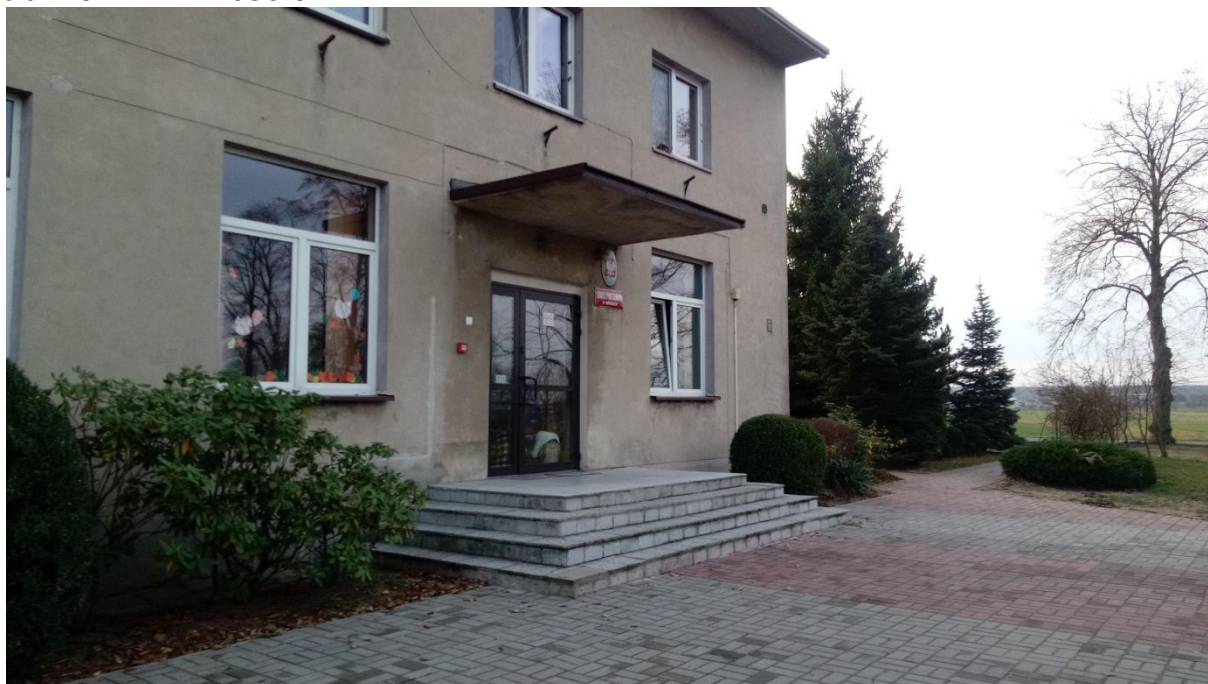
Zdjęcie 2 - Wejście do budynku - stan istniejący
